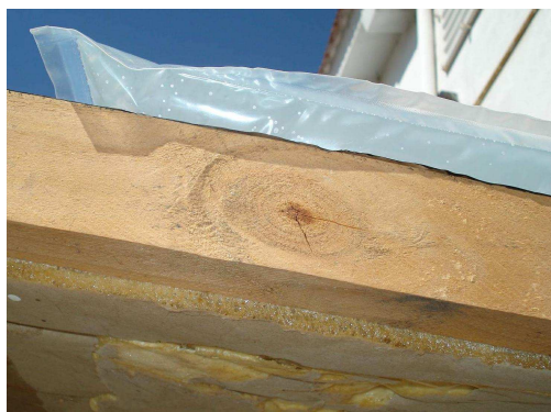
Figura 5: Aislación de poliuretano y marco de madera.
